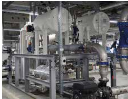
Bildet das Herz des neuen KWKK-Konzept bei Naarmann: die Absorptionskältemaschine von AKM (Foto: mi)
