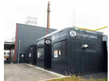
Bildet das Herz des neuen KWKK-Konzept bei Naarmann: die Absorptionskältemaschine von AKM (Foto: mi)
